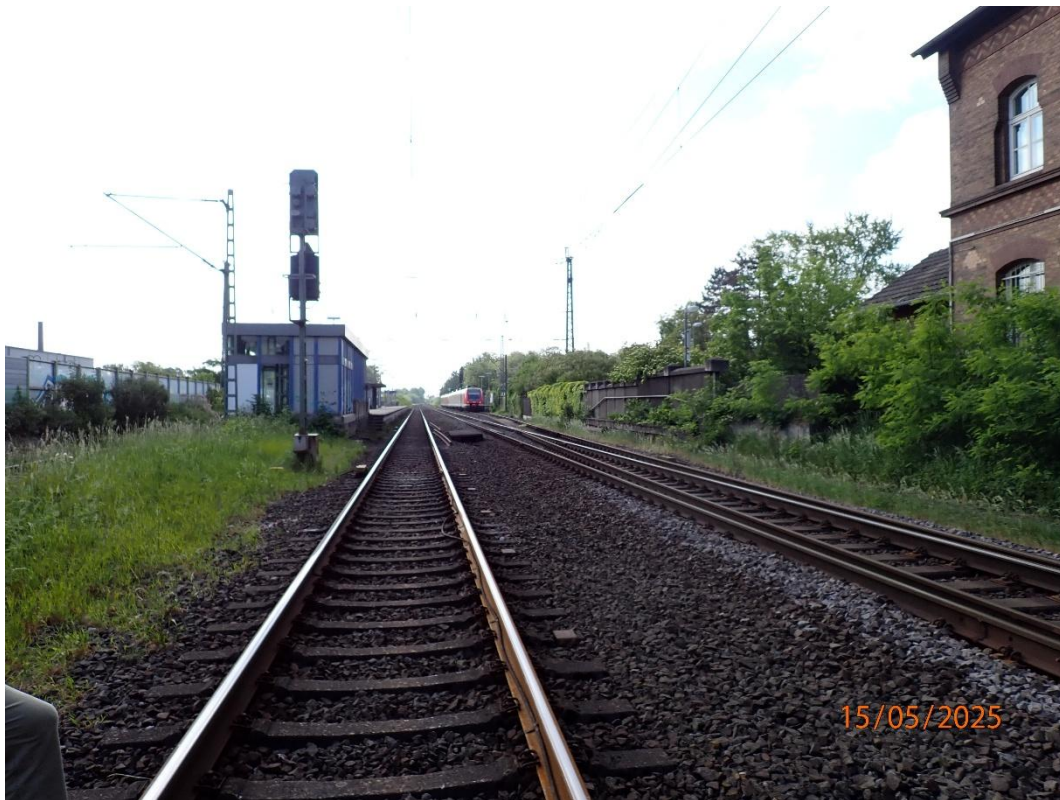
Bild 3: Bereich vor Bahnsteig mit Schwellenanker, km 29,818
