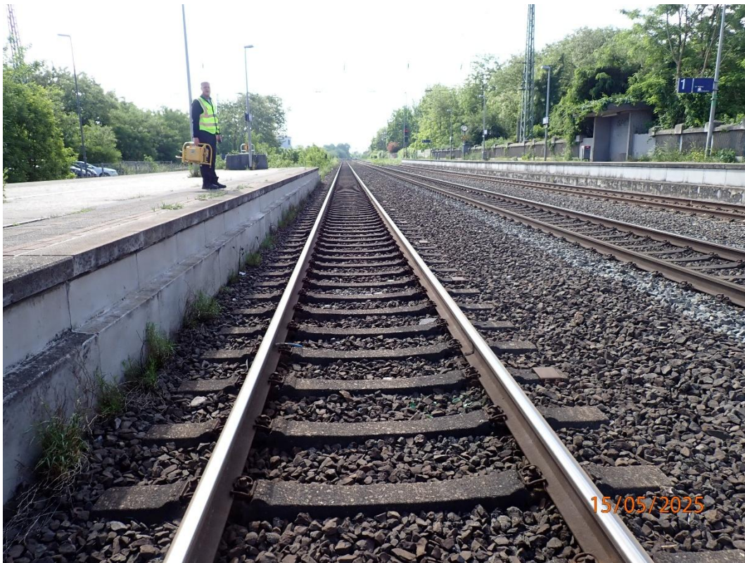
Bild 5: Schwellenanker im Bahnsteigbereich km 29,652
